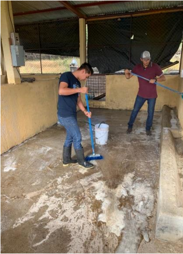
Limpieza de suelos y paredes
