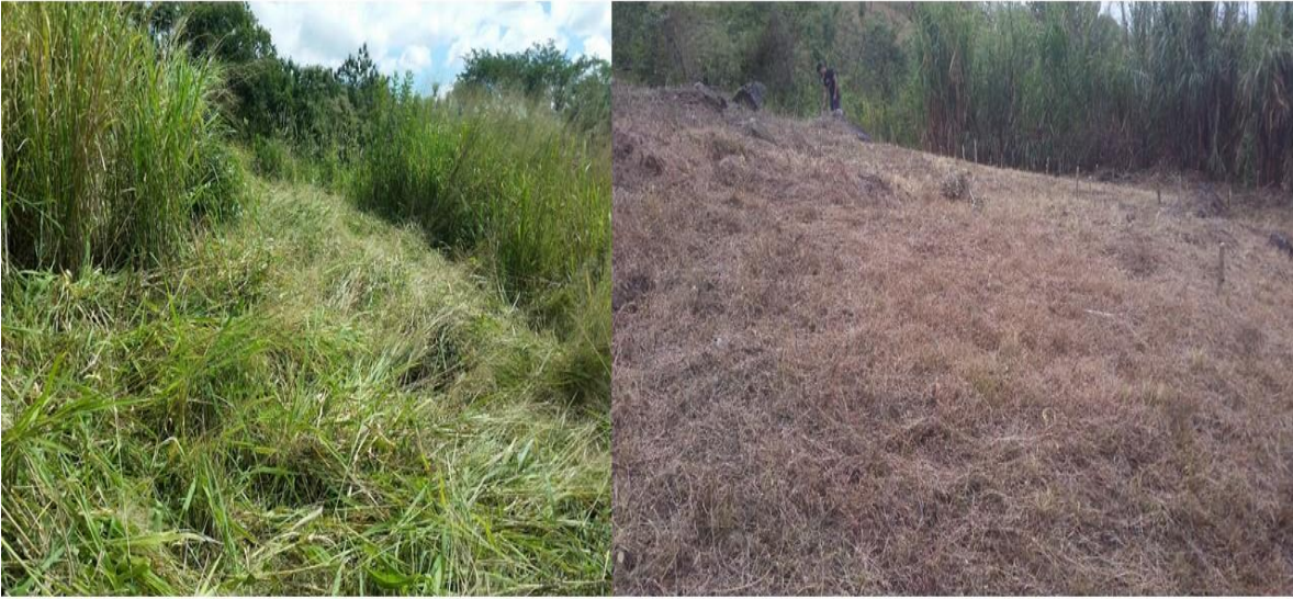
Limpieza del terreno
