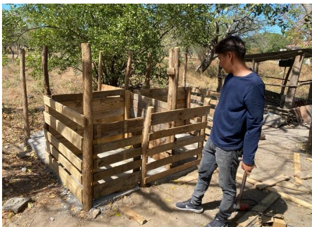
Realización de infraestructura
